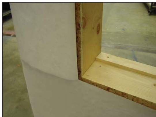
Figure 5. Appui en pente et barrage arrière
