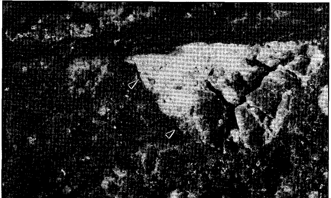
Figure 13. Vue en plan (grossissement 6 X) d'un granulat au fond d'une fraisure. L'emploi d'une fraiseuse a provoqué le bris du granulat et son décollage du liant bitumineux (flèches).
