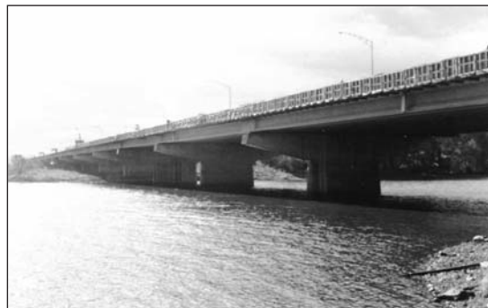
Figure 1. Le Pont Vachon, Laval (Québec), pendant sa réhabilitation, en 1996.
