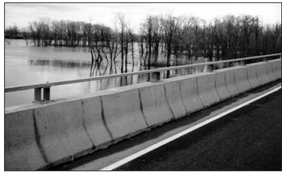
Figure 3. Travée typique du parapet après reconstruction.
