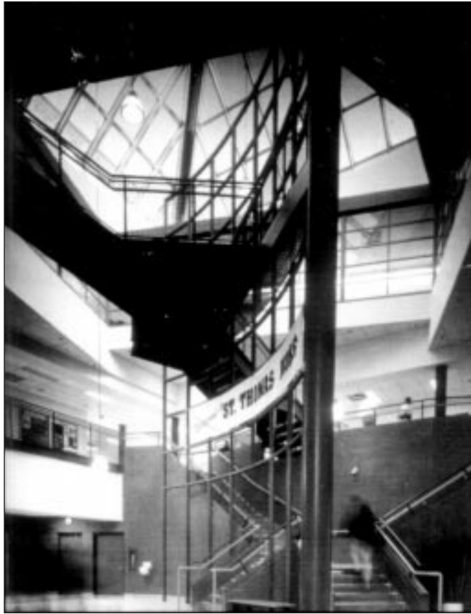
Figure 3. École récemment construite à Hamilton (Ontario); sa charpente comporte des poteaux d'acier remplis de béton armé traditionnel.
