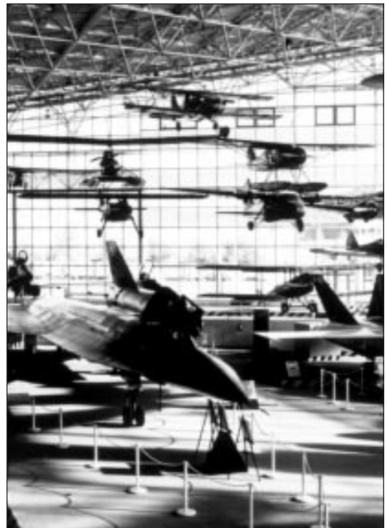
Figure 1. L'impression d'ouverture et de transparence qui se dégage du musée de l'aviation de Seattle (Washington) est due en partie à sa charpente en poteaux d'acier remplis de béton armé de barres.
