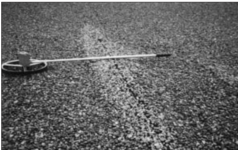
Figure 1. Des boursouflures se forment lorsque des poches d'air ou d'humidité emprisonnés entre les épaisseurs de la membrane ou entre celle-ci et le substrat se dilatent et déplacent la membrane.
